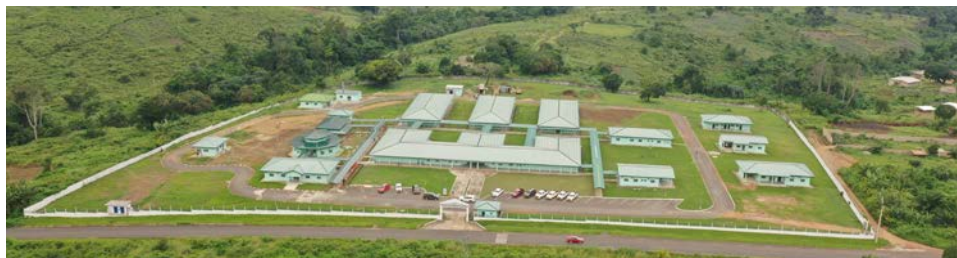
Vue aérienne de l'hôpital.
