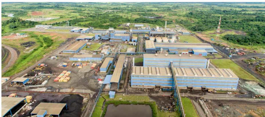
Vue aérienne du complexe métallurgique de Moanda.
