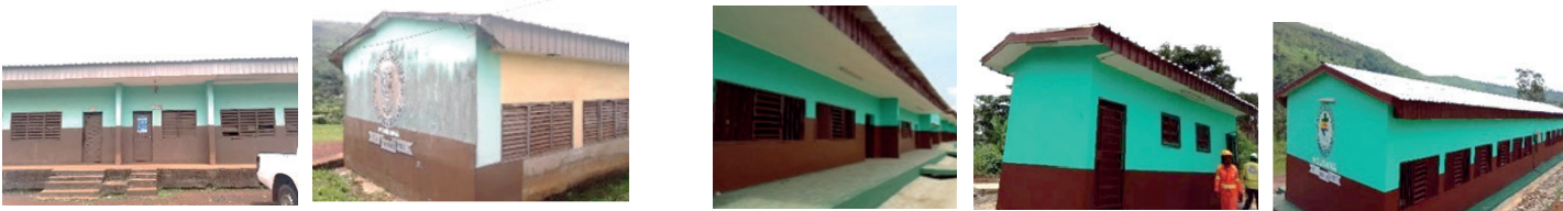
Image 8 : rénovation du Collège de Mounana
