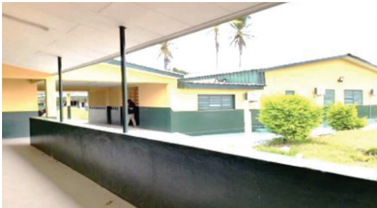
Image 4 : Travaux au centre médical de Bakoumba
