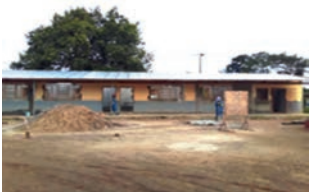
Image 9 : Travaux école catholique Saint Michel à Bakoumba
