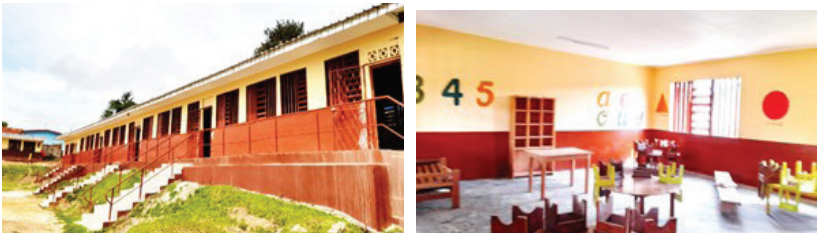
Image 4 : Réhabilitation de l'école Catholique Saint Dominique de Moanda
