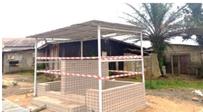
Image 3 : Réhabilitation des fontaines à Mounana
