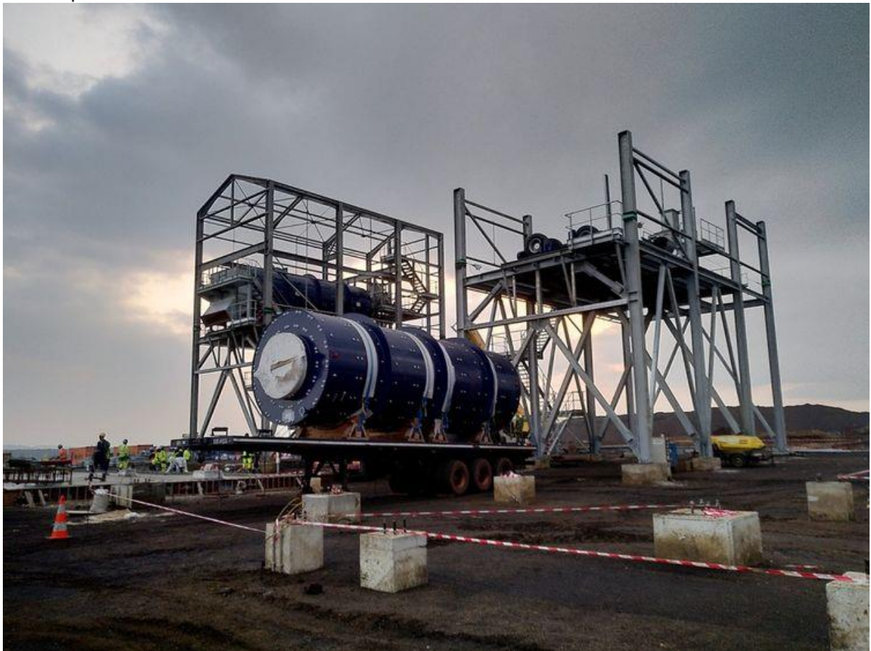
Les lignes de laverie en cours de montage sur le plateau d'Okouma. Etienne Goetz
